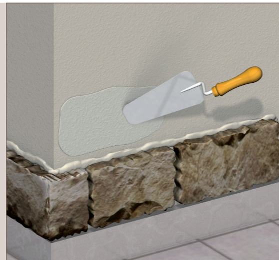
voile de mortier-colle même au mur
